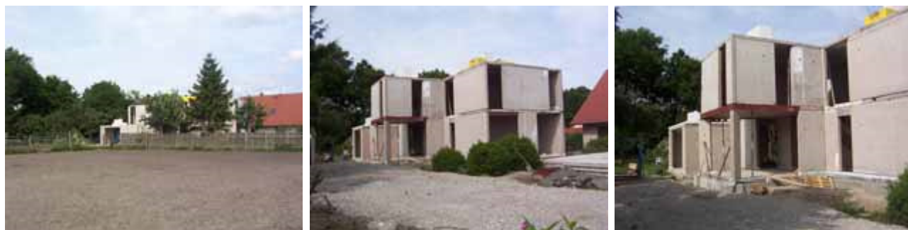
Baufortschritt Mitte Juli 2005
