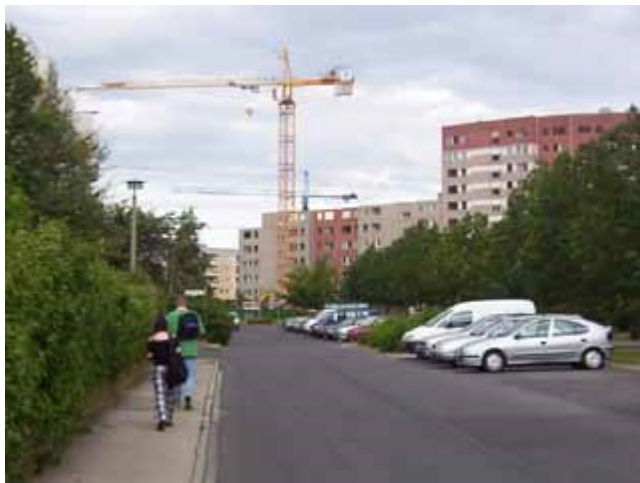
Demontage von 11-Geschossern in Marzahn
